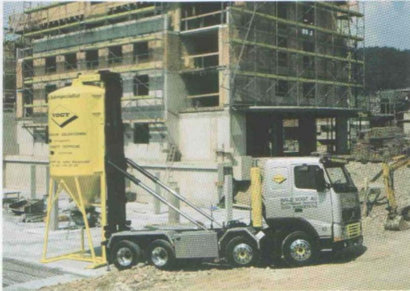
2-Kammer-Wechselsilo für Zementestrich
